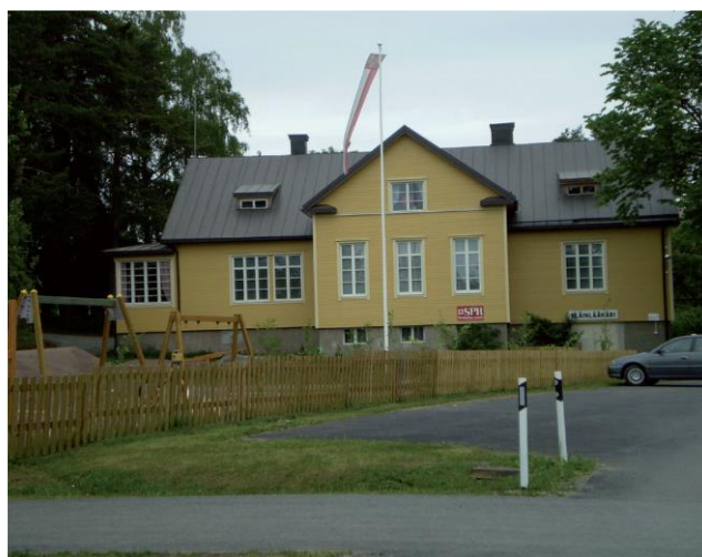
Kuva. Ala-Lepolan rakennus Tammelantien puolelta.
