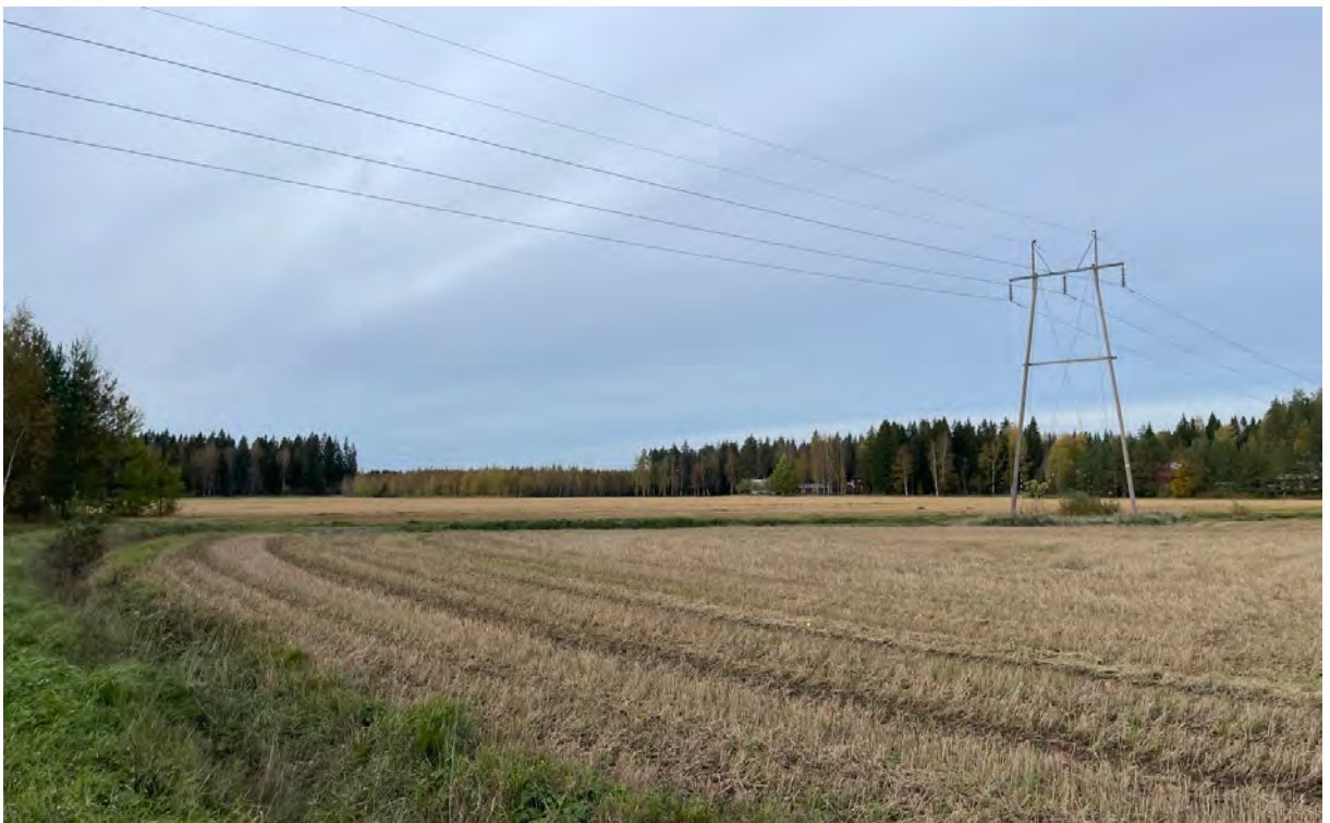
Kuva 21. Kuva Aromaan tilalle vievältä yksityistieltä luoteeseen (taustalla näkyy Salomaa ja kuvassa oikealla Ristikorpi) (kuva: A-Insinöörit, 2023).
