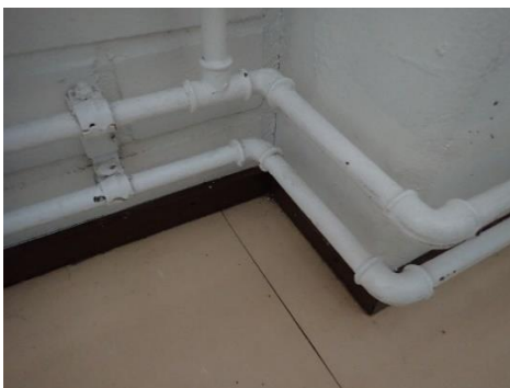
Kuva 14. Tiilikuurirakenteen ja betonirakenteen liittymässä on rako, jonka kautta rakenteesta voi virrata ilmaa huoneeseen, tila 1005.
