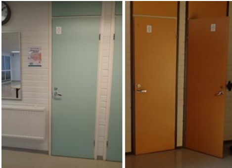
Kuva 26. Päärakennus, -81 osa, väliovia.
