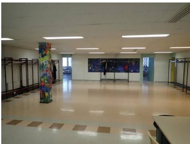
Kuva 4. Vuoden 1981 osalla lattiamateriaalina on pääosin erilaisia muovipäällysteitä.
