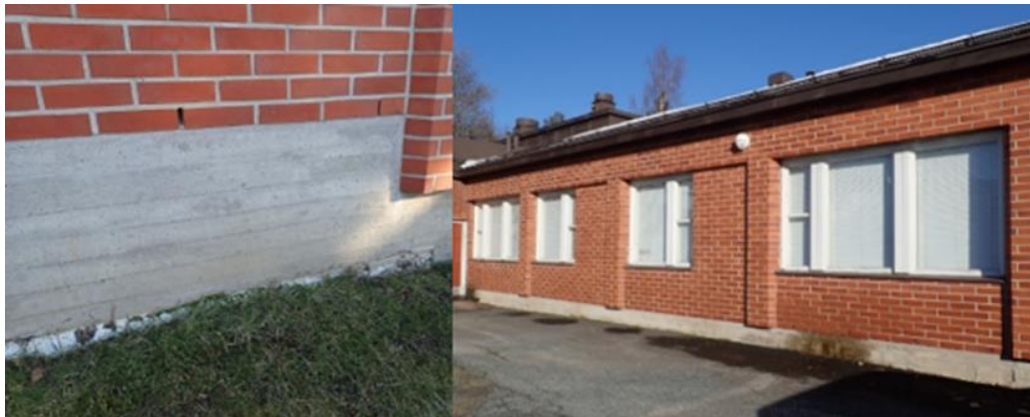
Kuva 10. Päärakennuksen osa vuodelta 1981, ulkoseiniä.
