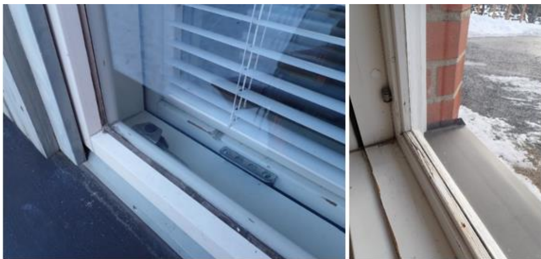
Kuva 43. Ikkunat ovat alkuperäisiä puuikkunoita.
