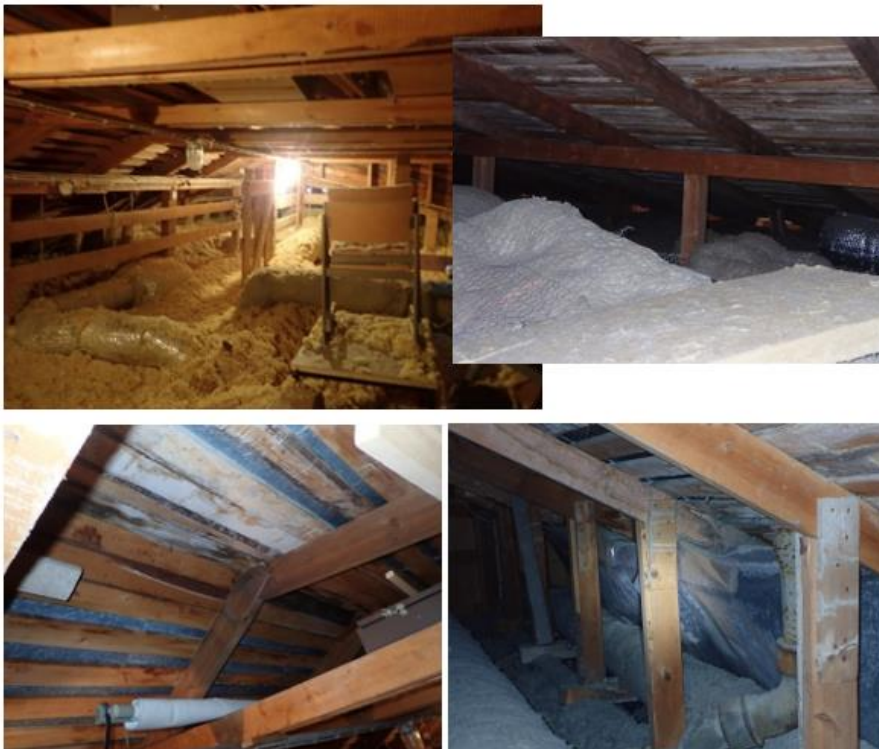
Kuva 31. Ullakko ja lämmöneristetila, päärakennuksen -59 osa.
