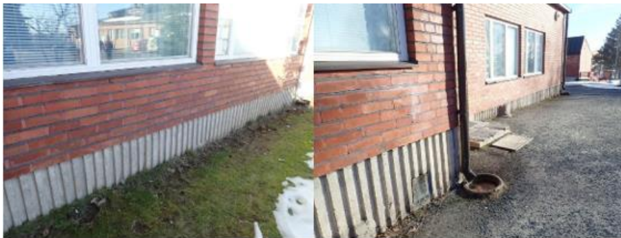
Kuva 8. Päärakennuksen vanhin osa on vuodelta 1959, ulkoseiniä.
