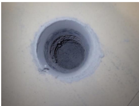
Kuva 18. Vuoden 1959 osalla välipohjassa on lastuvillasementtikerros pintalaatan alla.
