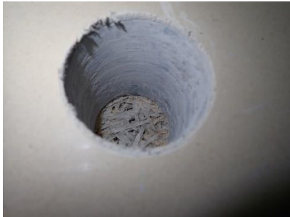
Kuva 3. Vuoden 1959 osalla alapohjissa ja välipohjissa on lastuvillasementtieriste.
