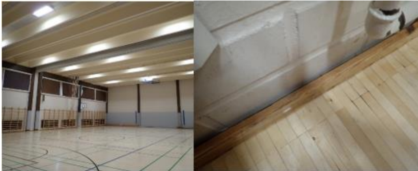
Kuva 5. Liikuntasalin puulattia tuulettuu reunojen kautta.
