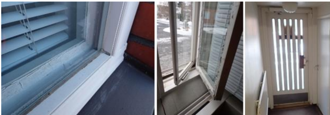
Kuva 36. Päärakennus -59 osa, ikkunoita ja ulko-ovi.
