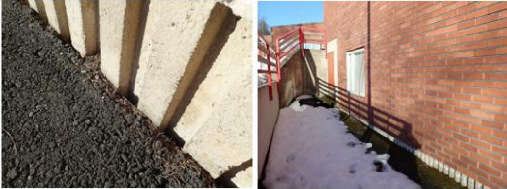
Kuva 37. Lisärakennus -59, sokkelit ja julkisivua.
