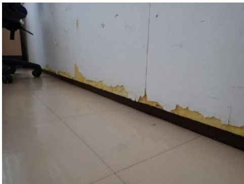
Kuva 20. Musiikkiluokassa -59 osalla väliseinän mineraalivillapintoja, kuitulähde.
