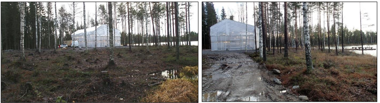
Saunan työmaa ja rantaa.
